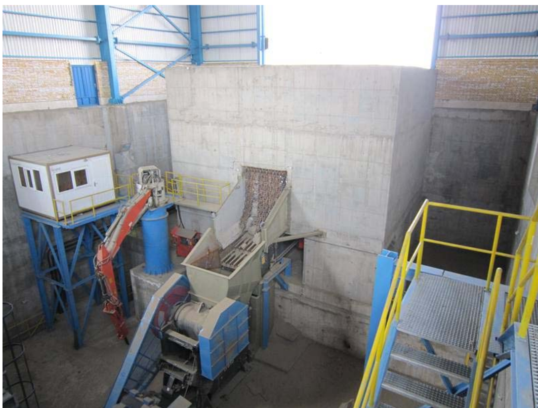
سنگ شکن پروژه پلی کام (گل گهر سیرجان)
