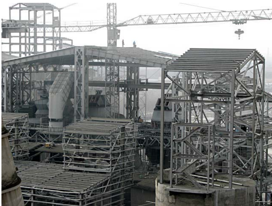
سازه ساختمان آسیاب سیمان (کارخانه سیمان آبیگ)
