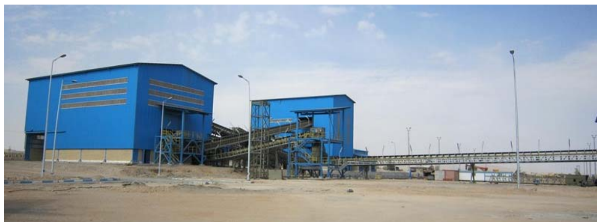
ساختمان های سرد و سنگ شکن ثانویه و کانوایرهای رابط پروژه پلی کام (گل گهر سیرجان)
