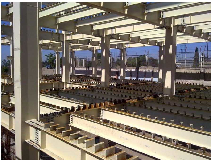
سازه ساختمان تحقیقات و توسعه (شرکت سایپا)
