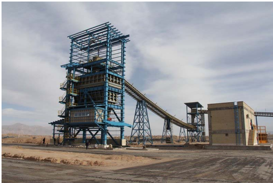
ساختمان بارگیری کامیون و کانوایر آن در پروژه سیسکو (گل گهر سیرجان)
