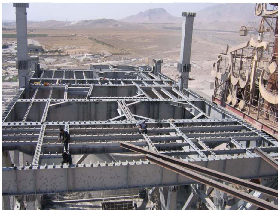
سازه ساختمان پیش گرمکن به ارتفاع ۱۴۰ متر (کارخانه سیمان آبیک)
