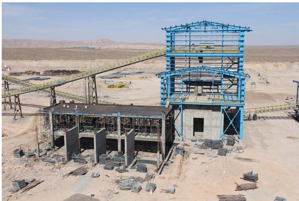
ساختمان‌های آسیای مجدد و اتاق برق پروژه گلفا (گل گهر سیرجان)
