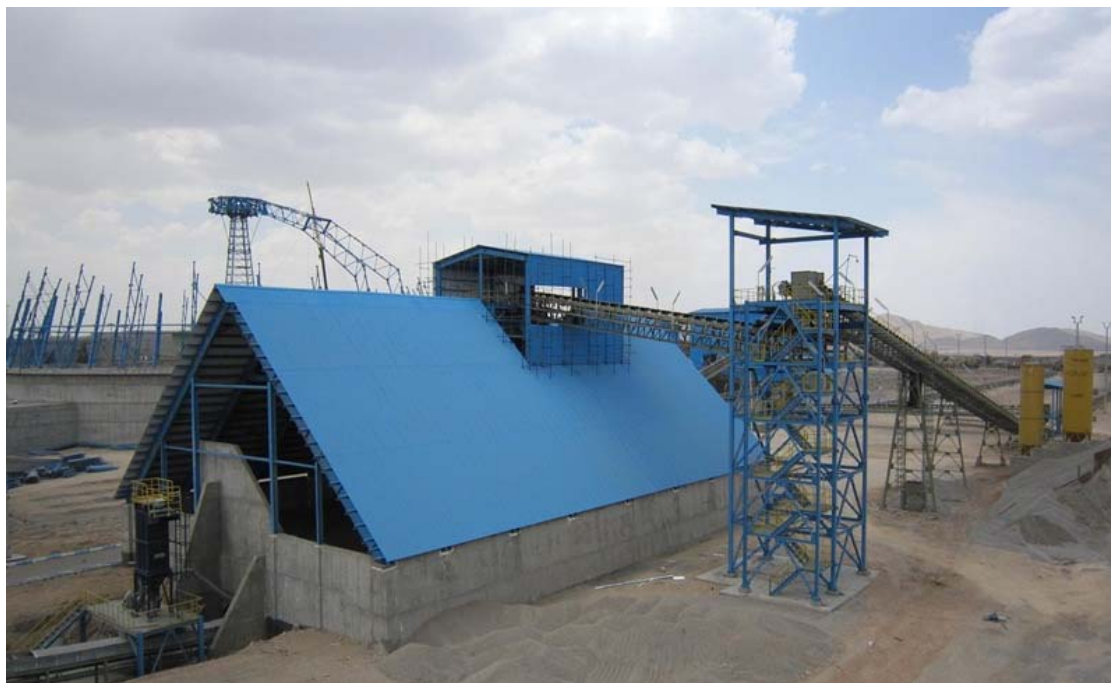
سازه فیدینگ پروژه پلی کام (گل گهر سیرجان)
