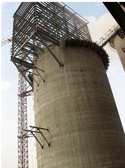
سازه سيلوی هموزن ساز به ظرفيت ۱۲۵۰۰ تن به قطر ۱۶ متر و ارتفاع ۷۹ متر (کارخانه سیمان آبيک)
