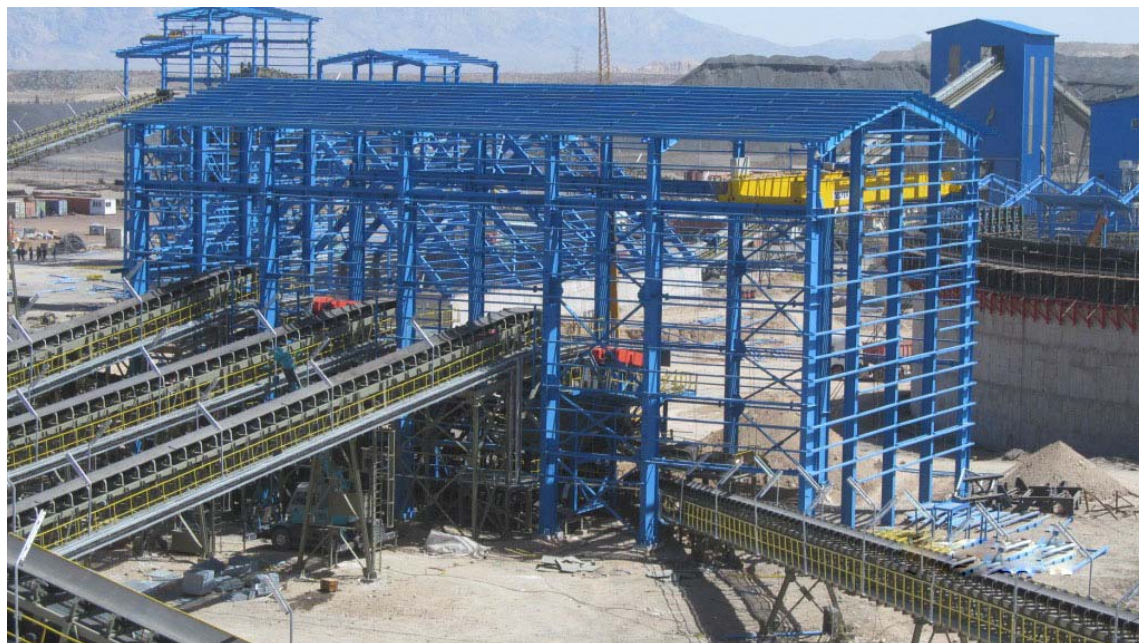
سازه سرنند و کانوایرهای پروژه پلی کام (گل گهر سیرجان)
