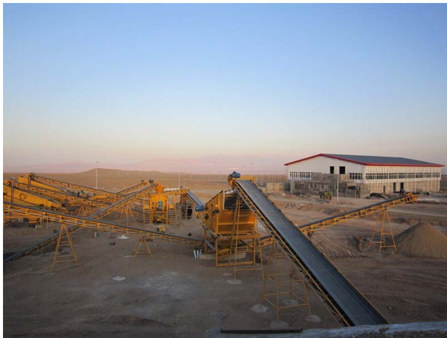
کارخانه تولید قطعات پیش ساخته بتنی (دلیجان - اراک)
